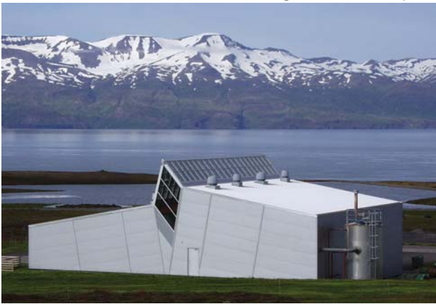
Das geothermale Kalina Kraftwerk in Husavik
