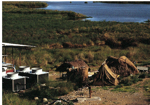
DAL – Kapisya (Zambia) – 1988 2 X 100 kWel Geothermal source: 88 °C
