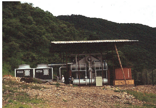
DAL – Kapisya (Zambia) – 1988 2 X 100 kWel Geothermal source: 88 °C
