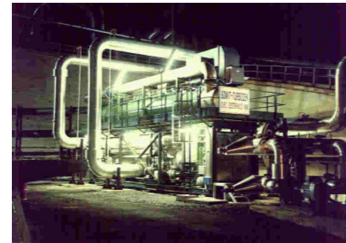
Enel Castelnuovo Val di Cecina 1,3 MWel Geothermal source: 114 °C
